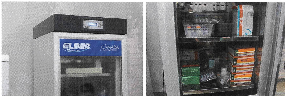
Visão externa e interna da câmara conservadora que armazena as vacinas do município de Monte do Carmo – TO
