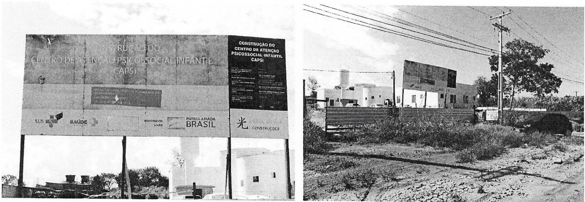
Placa indicativa e entrada da obra sem asfalto
