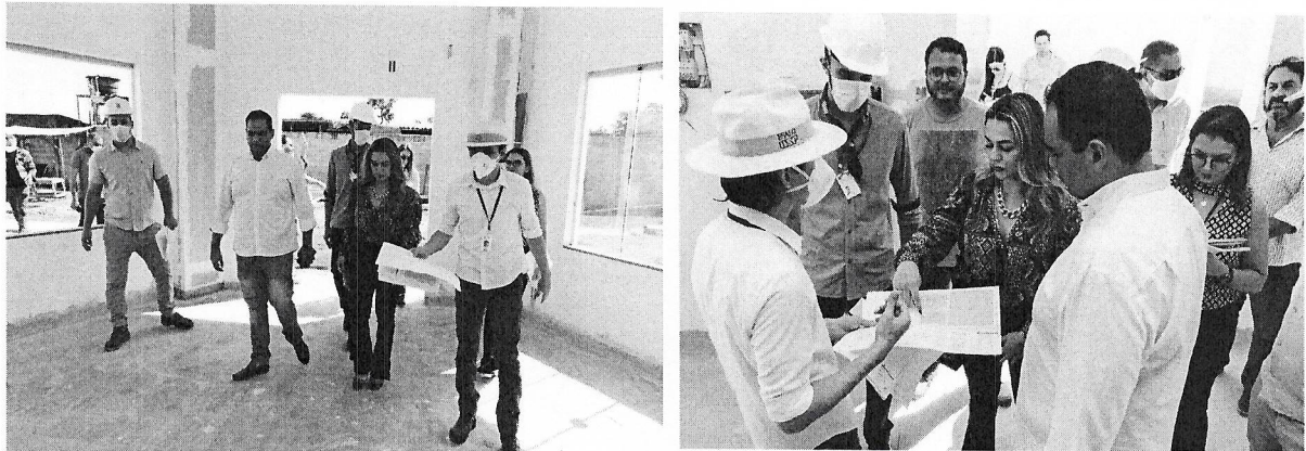
Momento da vistoria na parte interna da obra
