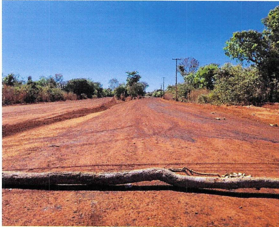
Obra da Av. LO-31
