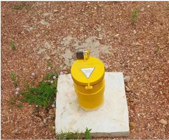
Foto 154: Piezômetro instalado no aterro sanitário.
