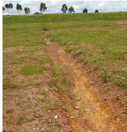
Foto 155: Vala utilizada para a drenagem das águas superficiais.
