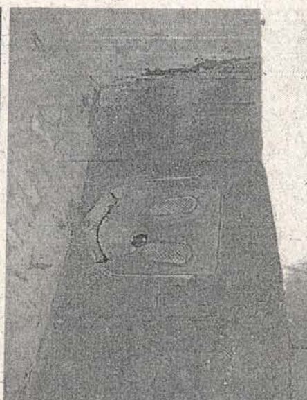
Imagem 2 – Vista do sanitário dos alojamentos;
