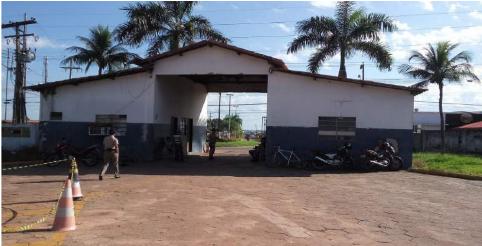
Imagem 22: Vista interna Corpo da Guarda
