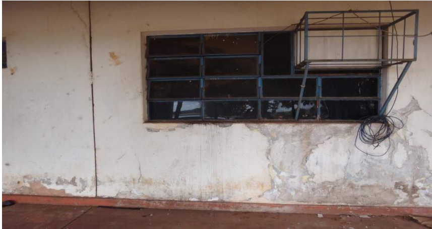
Imagem 08: Paredes área externa do pavilhão 02
