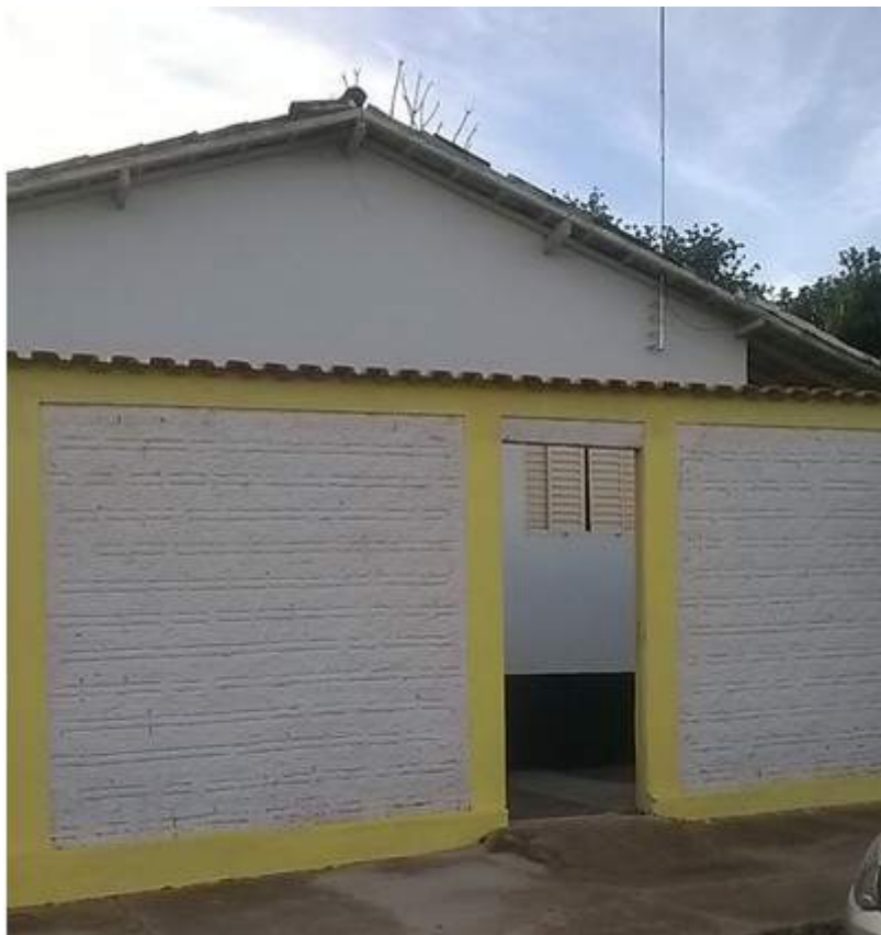
Imagem 32: Vista externa do Destacamento de Muricilândia/TO
