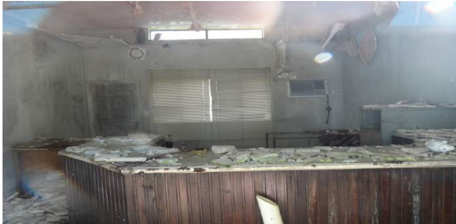
Imagem 10: Pavilhão de trânsito (interno)
