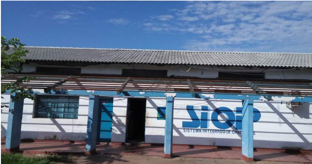
Imagem 16: Fachada do SIOP - Telhado de área descoberto
