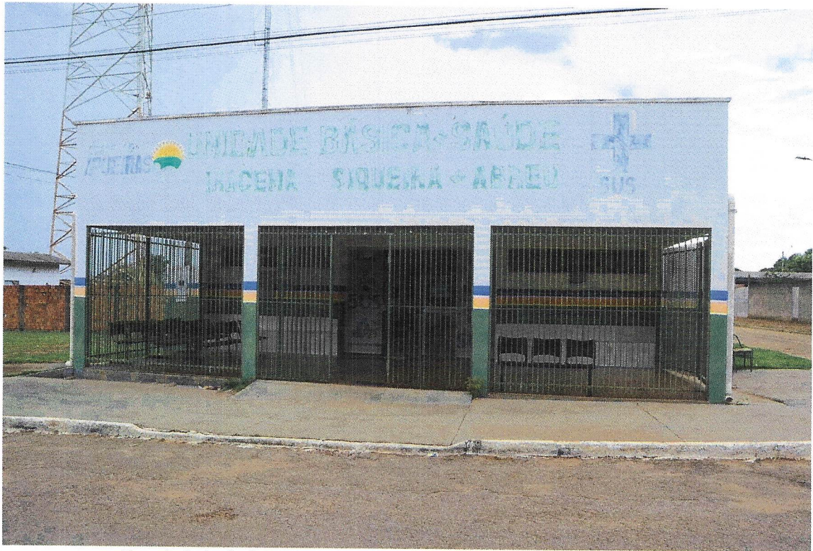
Foto da fachada da UBS Iracema Siqueira de Abreu Oliveira em Ipueiras - TO
