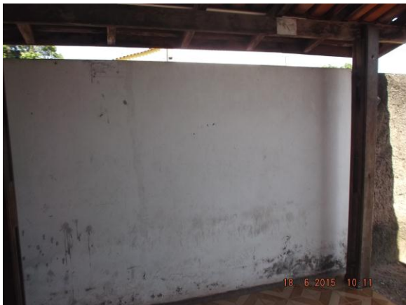
Infiltração nas paredes da Delegacia de Santa Fé do Araguaia
