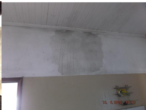
Infiltração nas paredes da Delegacia de Santa Fé do Araguaia
