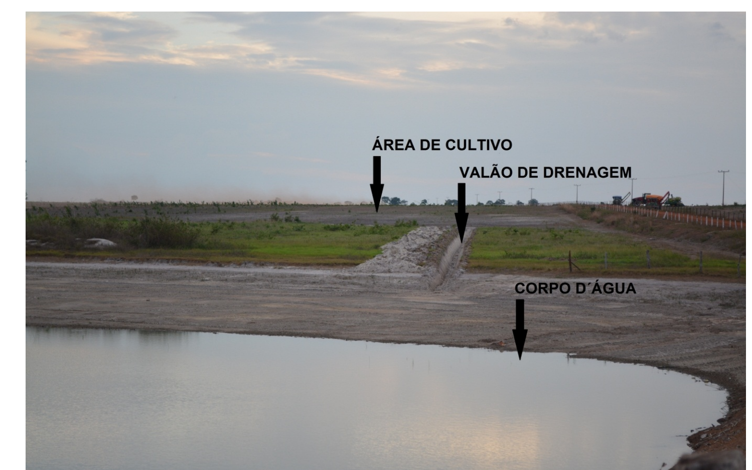
Figura 05 – Valão de drenagem objetivando o escoamento de água da área de cultivo de soja para dentro do corpo d'água da APA Ilha do Bananal/Cantão. Foto: Próprio autor.
