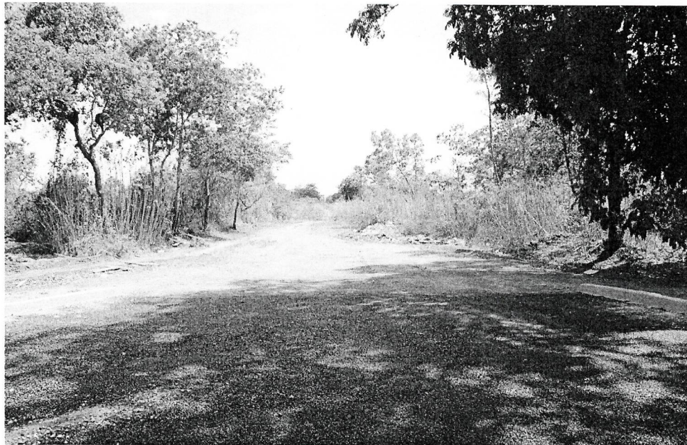
Rua interna a ser aberta
