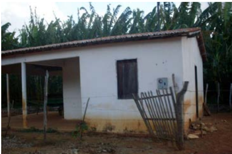
Figura 2.9 - Contiguidade entre as áreas de plantio e as residências
