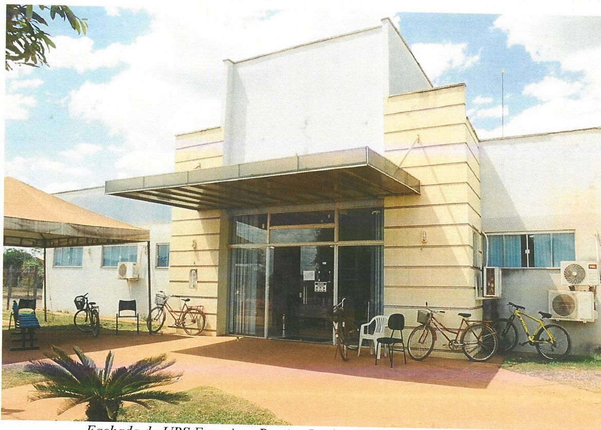
Fachada da UBS Francisco Pereira Rocha em Bom Jesus do Tocantins
