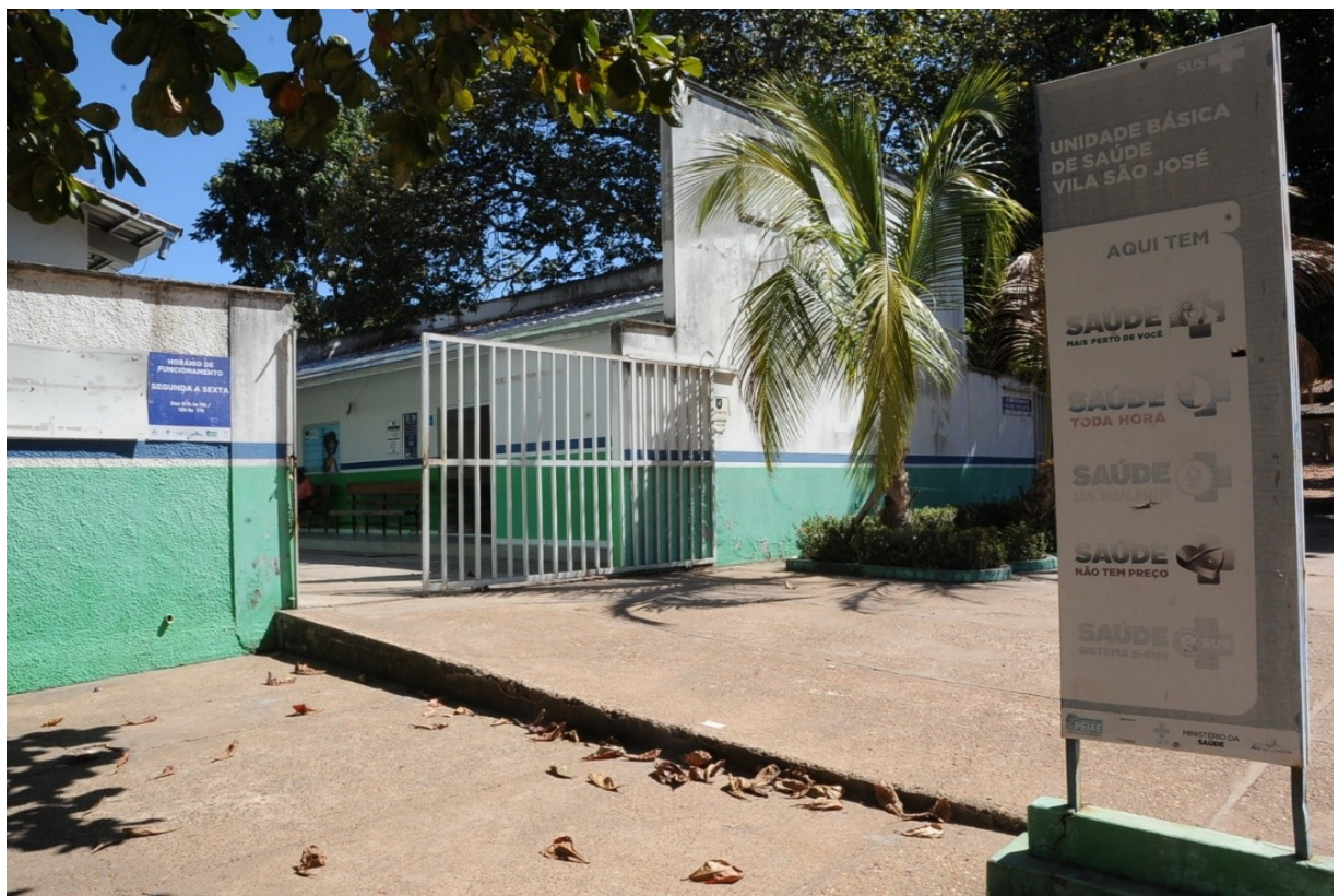
Foto da vista frontal da UBS Vila São José
